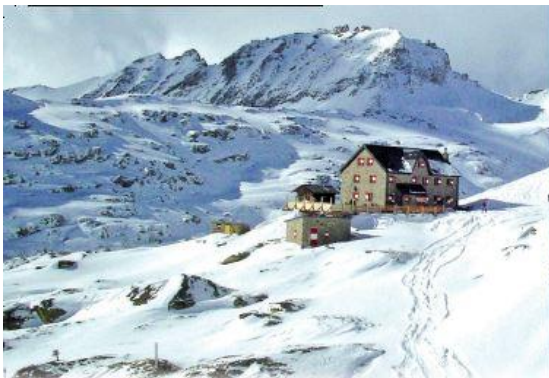
Widok na Schronisko z wjazdem na „Duisburger Rinne”
